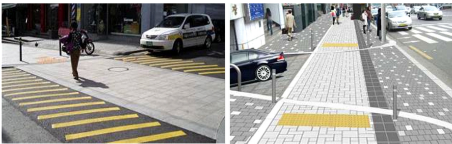
[보도단절구간 횡단보도 설치]
