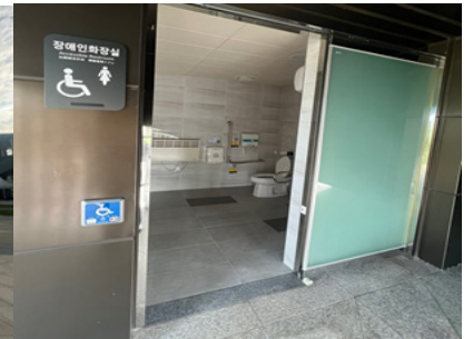
블라드 또는 주요 구간 점자블록 미설치(X)
