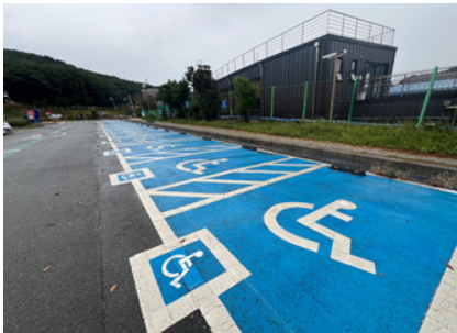
태종대 정문 장애인 주차장 17면(○)
