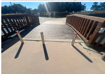
볼라드 앞 미설치된 점자블록
